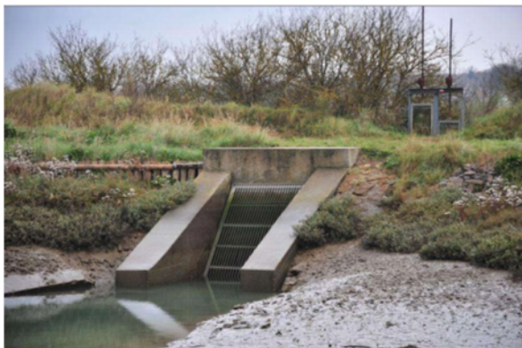
Figure 32. Vanne à crémaillère au débouché des terrains François (vanne principale). Source : PNA, Février 2017.
